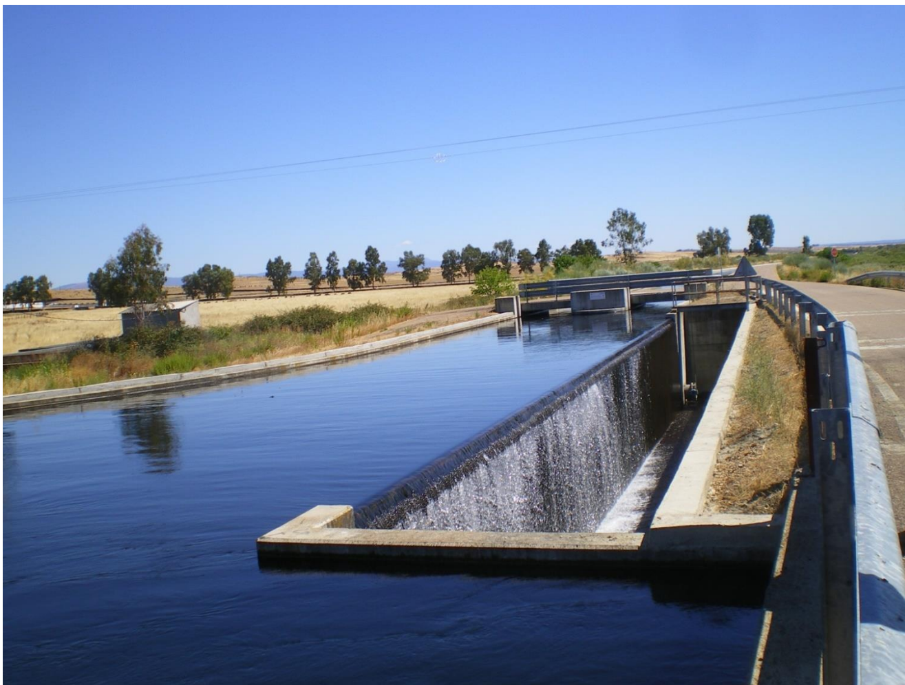
Figura 2 Aliviadero Lateral en el Canal de Sierra Brava.
