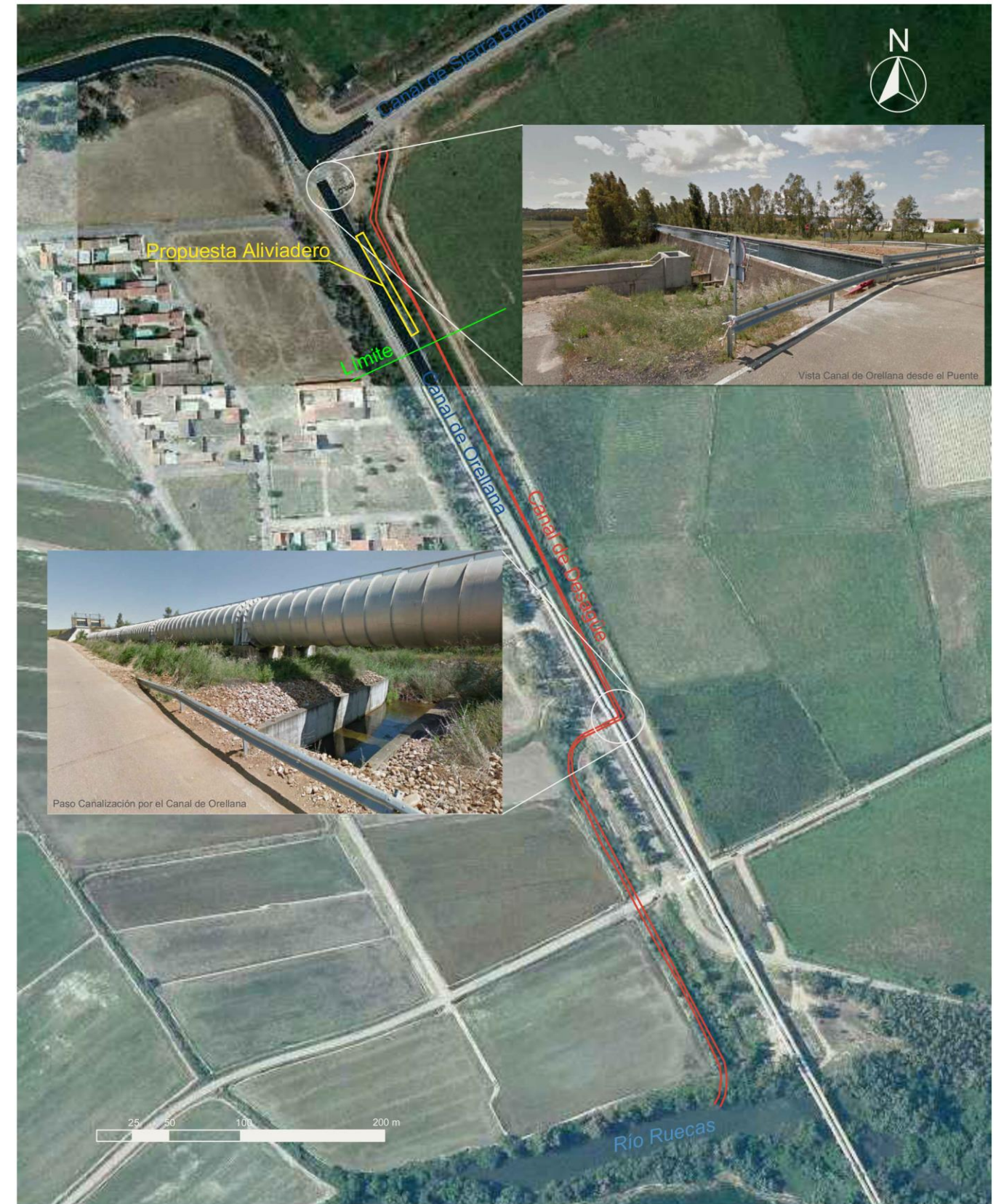
Figura 4 Recorrido Canal de Desagüe.
