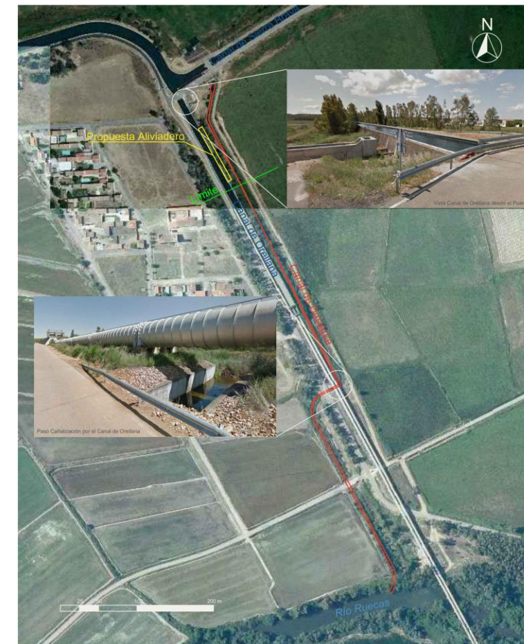
Figura 1 Recorrido Canal de Desagüe.
